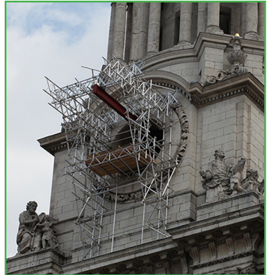
I planeringsstadiet får man inte glömma säkerhetsaspekter. Designen måste vara hållfast och inte innebära en risk för olycker. Renovering av St Pauls Cathedral, London.
